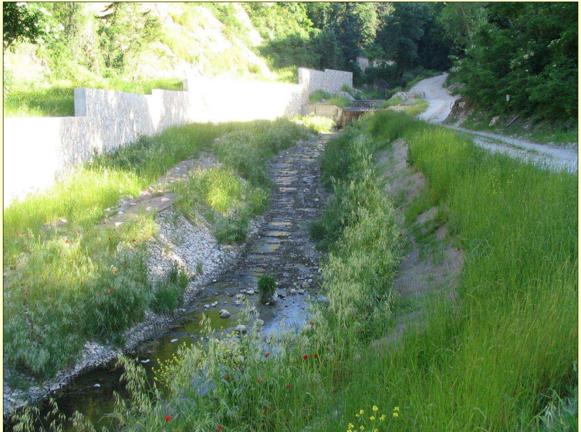
Materassi spondali e biostuoia in juta seminata con loietto italico - Comune di Orsara di Puglia (Fg) Canale S. Rocco - Cupa Foto di M. Frisoli
