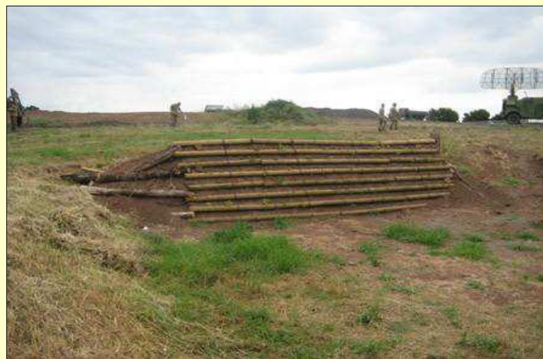
Costruzione di una Palificata Loricata nel Parco tecnico-scientifico del Genio Militare a Roma Foto P. Cornelini
