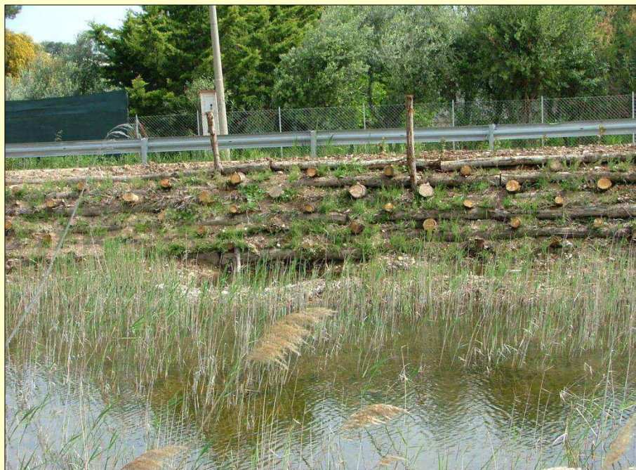
Palificata viva spondale a doppia parete (località Molinella, Comune di Vieste (FG) Foto G. Russo)
