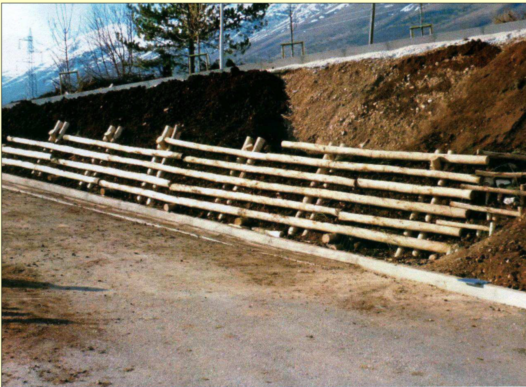
Esempi di palificata l'Aquila in costruzione
