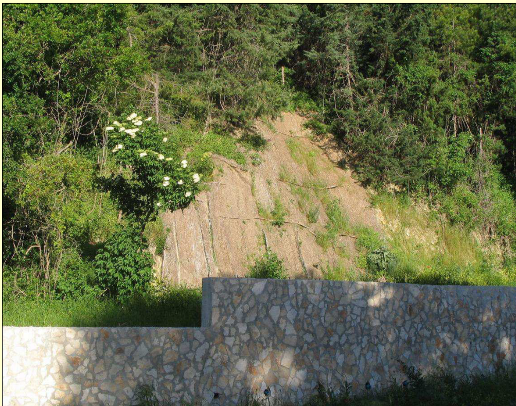
Rivestimento di biostuoia in juta su versante con messa a dimora di talee Comune di Orsara di Puglia (Fg), Foto di M. Frisoli
