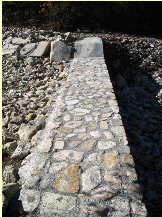
Briglie in muratura ordinaria costruite negli anni '60 e da poco restaurate. Comune di Celle di San Vito (Fg) - Fosso Fontanelle Progetto e D.L. S. Puglisi e P. La Cava Foto M. Frisoli
