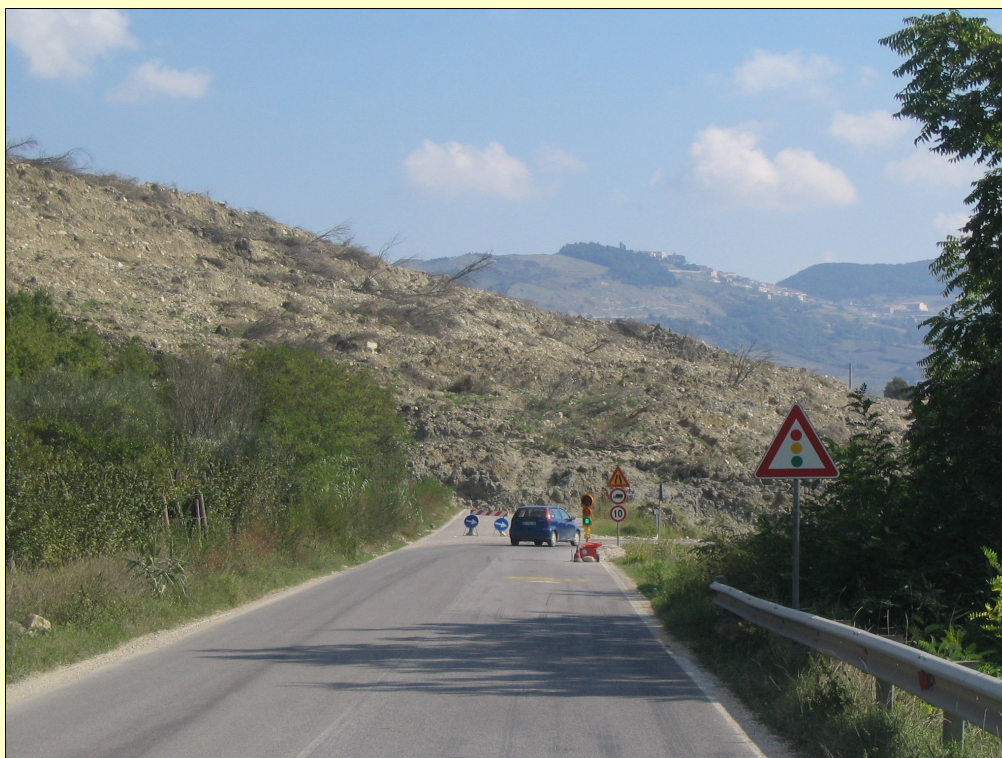
Frana di Montaguto (Fg) Foto M. Frisoli
