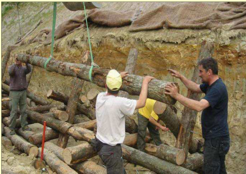
Palificata Roma in costruzione Foto P. Cornelini
