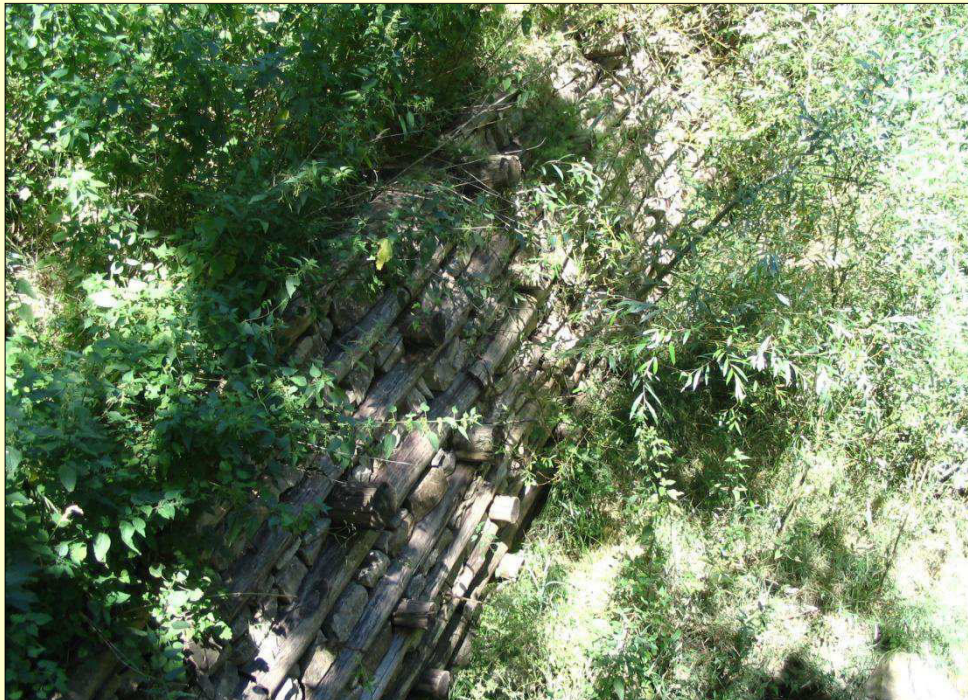
Palificata di versante a doppia parete - Comune di Celle San Vito (Fg) Progetto e D.L. S. Puglisi e P. La Cava Foto M. Frisoli
