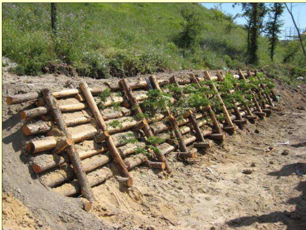
Palificata Roma ultimata Foto P. Cornelini
