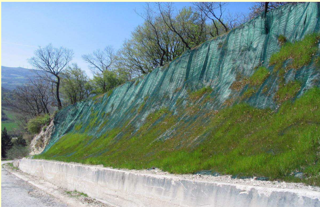
Scarpata stradale rivestita con biostuoia tridimensionale sintetica, con biofiltro di cellulosa preseminato, talee, arbusti autoctoni - Comune di Orsara di Puglia (Fg), Foto M. Frisoli
