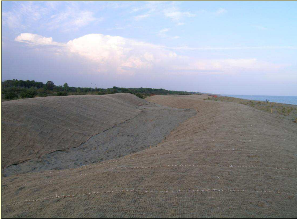
Ricostituzione dunale in fase di realizzazione, anno 2008 Località Riserva Naturale Orientata "Bosco Pantano di Policoro", Comune di Policoro (MT) Realizzazione CODRA Mediterranea Foto L. Forte
