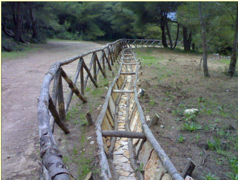
Canaletta in legname e pietrame Comune di Tremiti (Fg) Isola di San Domino Progetto Consorzio di Bonifica Montana del Gargano Foto G. Russo
