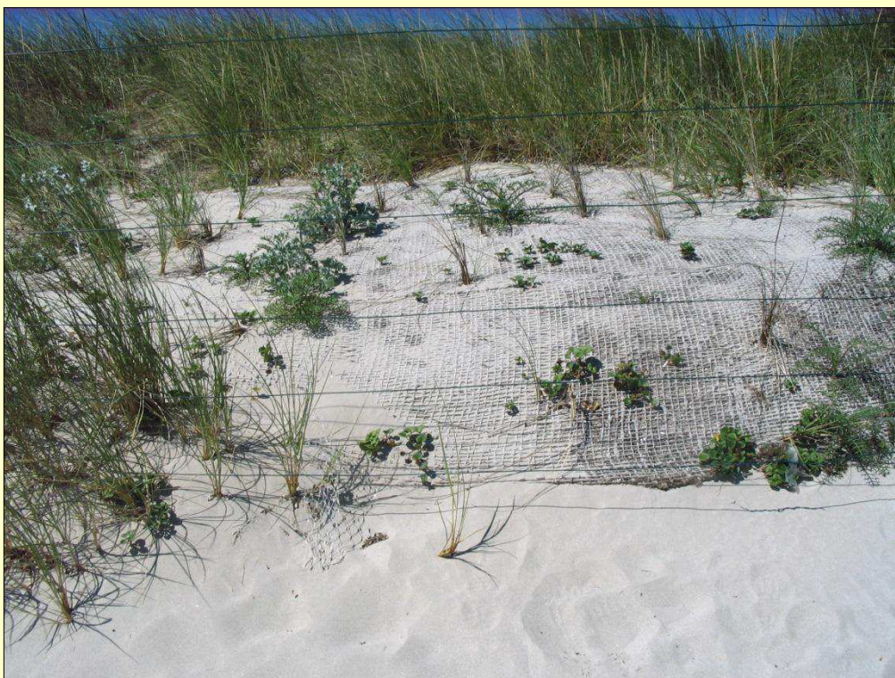
Rivestimento con biorete in juta su duna di sabbia - Torre Guaceto - Comune di Carovigno (Br), Foto M. Frisoli
