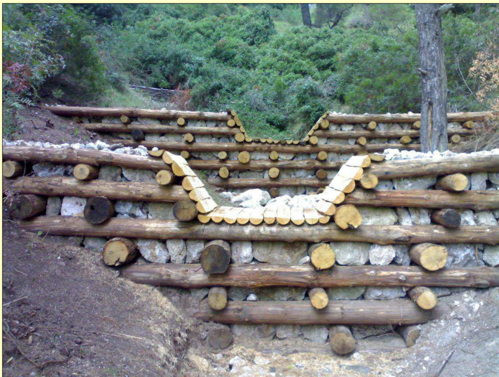
Briglia in legname e pietrame Comune di Celle San Vito (Fg) - Località Fosso Fontanelle Progetto e D.L. S. Puglisi e P. La Cava Foto P. La Cava
