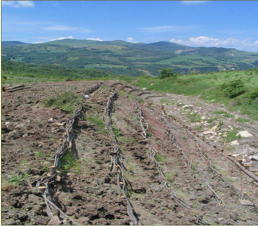
Graticciata viva Comune di Celle S. Vito (Fg) – Località Torrente Perraglia Foto M. Frisoli
