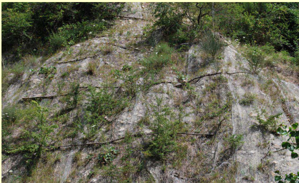
Rivestimento di versante roccioso con rete metallica zincata a doppia torsione e biostuoia in juta e messa a dimora di arbusti - Comune di Orsana di Puglia – FG Foto M. Frisoli
