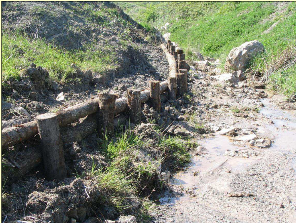
Palizzata con tronchi di castagno in fase di completamento – Comune di Celle S. Vito (Fg) Torrente Perraglia Foto M. Frisoli
