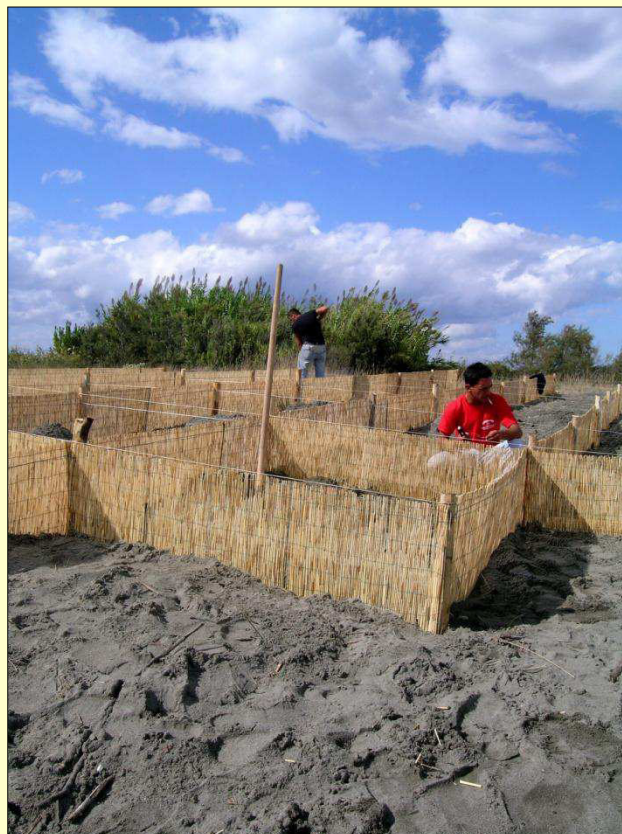
Schermi frangivento a scacchiera in fase di realizzazione. Località Riserva Naturale Orientata "Bosco Pantano di Policoro", Comune di Matera (MT) Foto L. Forte
