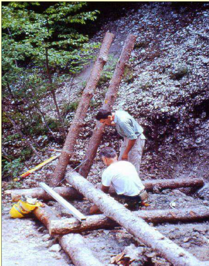
Palificata tipo Roma in costruzione. Gola del Furlo (PS) - Foto P. Cornelini
