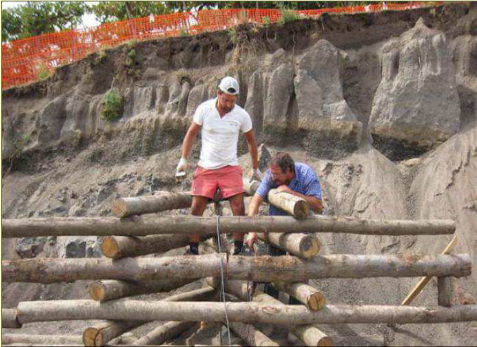
Palificata Latina in costruzione Foto P. Cornolini
